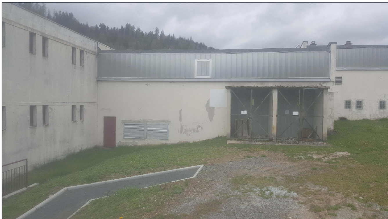
Bât D - Photo Façade EST ETAT ACTUEL
