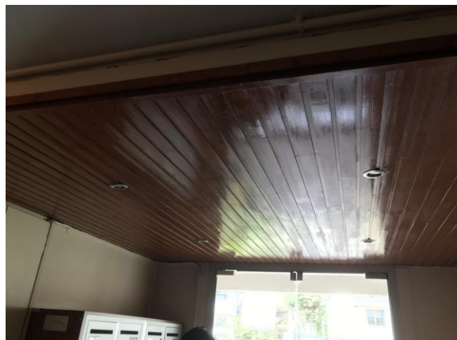
ESCALIER BATIMENT LOGEMENTS
