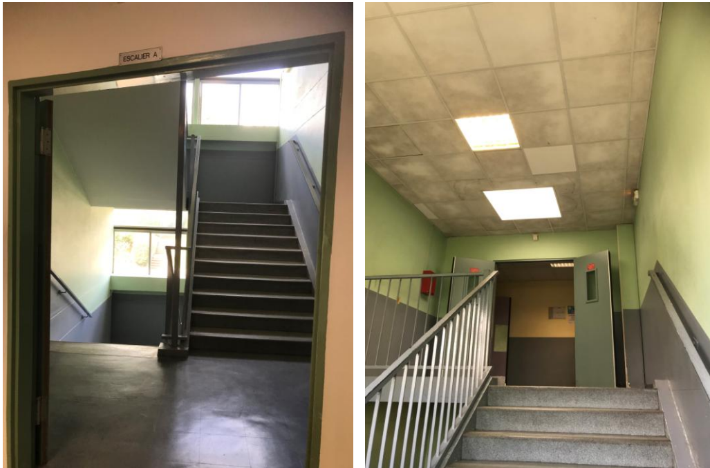
ESCALIER A BATIMENT A
