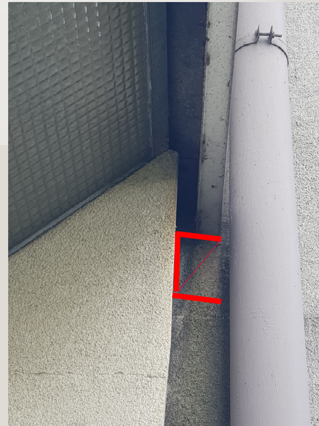
Création d'une ossature métallique linéaire servant d'appui aux futures façades en polycarbonate, fixées sur les têtes de poteaux de façade
