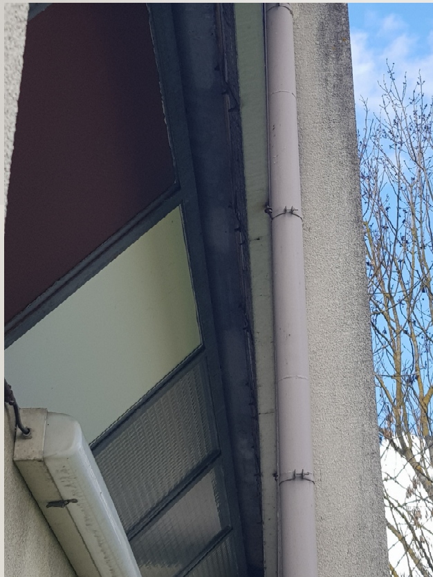
Dépose des châssis métalliques et traitement en isolation
