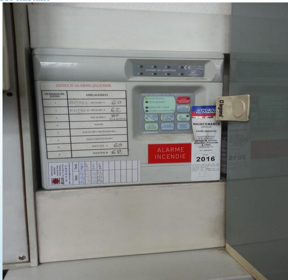
BAAS pr : Matériel central d'un Equipement d'Alarme de type 2b
