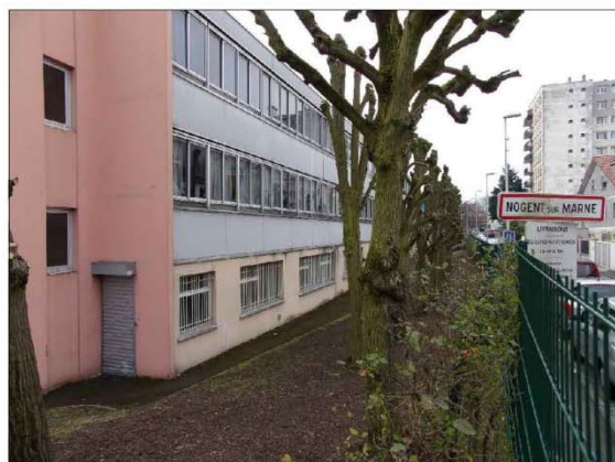
C.07 : Arrière bâtiment - Rue Maréchal Joffre
