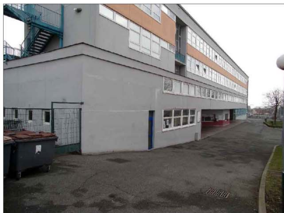
C.08 : Accès livraisons #1 - Rue Maréchal Joffre
