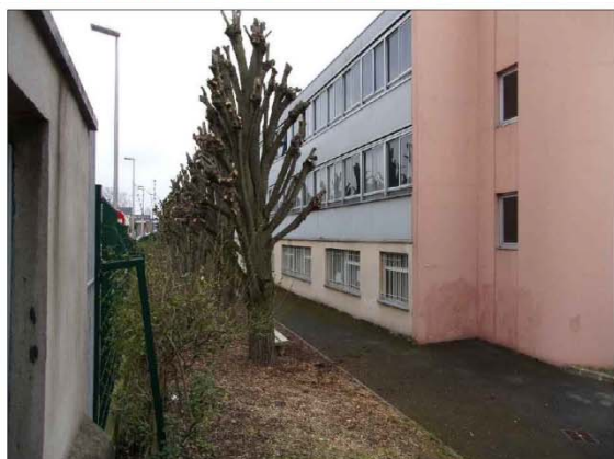
C.06 : Arrière bâtiment - Rue Maréchal Joffre
