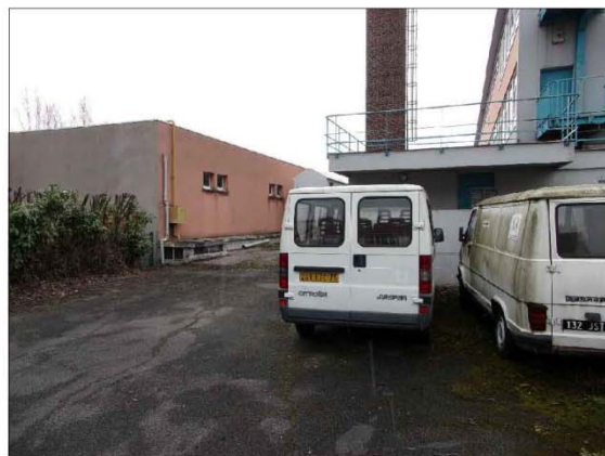
C.09 : Accès livraisons #2 - Rue Maréchal Joffre
