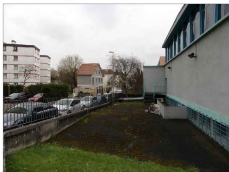
C.04 : Issue gymnase - Rue Maréchal Joffre
