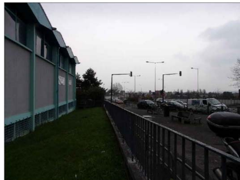
C.03 : Façade du gymnase - Bvd de Strasbourg
