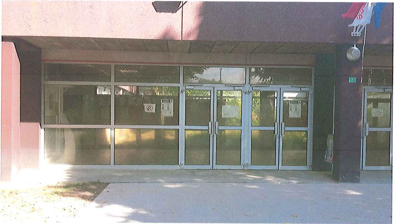
ENSEMBLE NENUISE EXISTANT PARTIE GAUCHE
