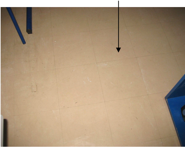
Echantillon N°1 Dalle de sol Absence d'amiante
