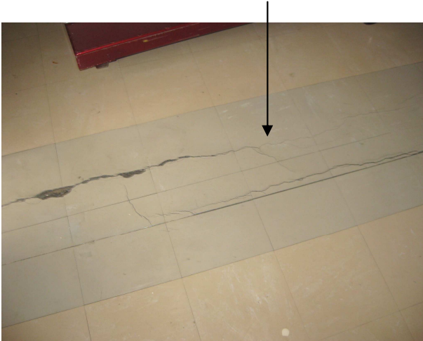
Echantillon N°5 Dalle de sol Absence d'amiante
