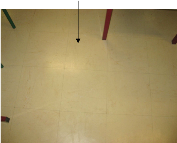
Echantillon N°3 Dalle de sol Absence d'amiante
