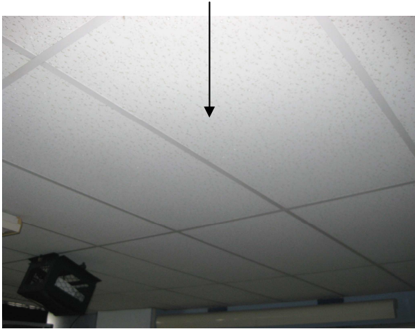
Echantillon N°2 Faux-plafond Absence d'amiante
