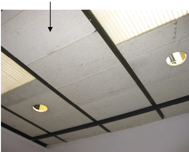
Echantillon N°4 Faux-plafond Absence d'amiante
