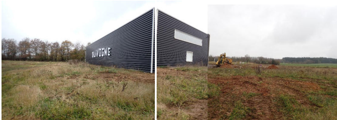
Vue de la plate-forme vers le Nord-Ouest Pelle en F12
