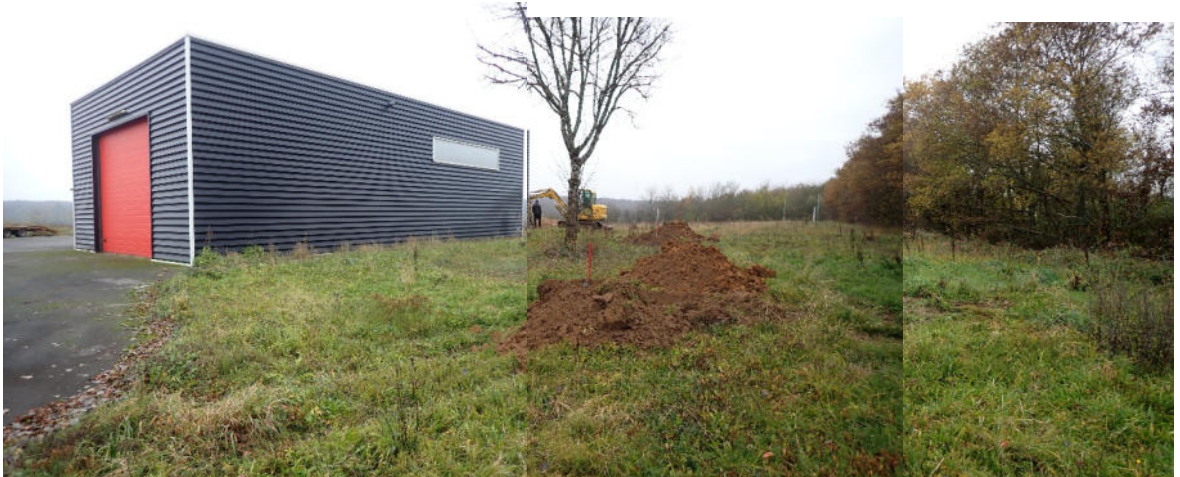
Vue vers le Sud à l'Ouest du bâtiment existant (Pelle mécanique en FR4)
