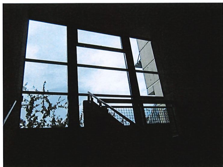
Nettoyage 2 faces baies vitrées cages d'Escaliers
