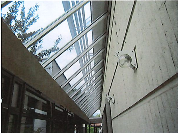
Nettoyage 2 faces des verrières des couloirs en toiture
