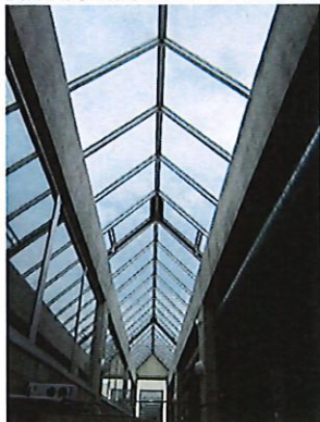
Nettoyage 2 faces des verrières en toiture
