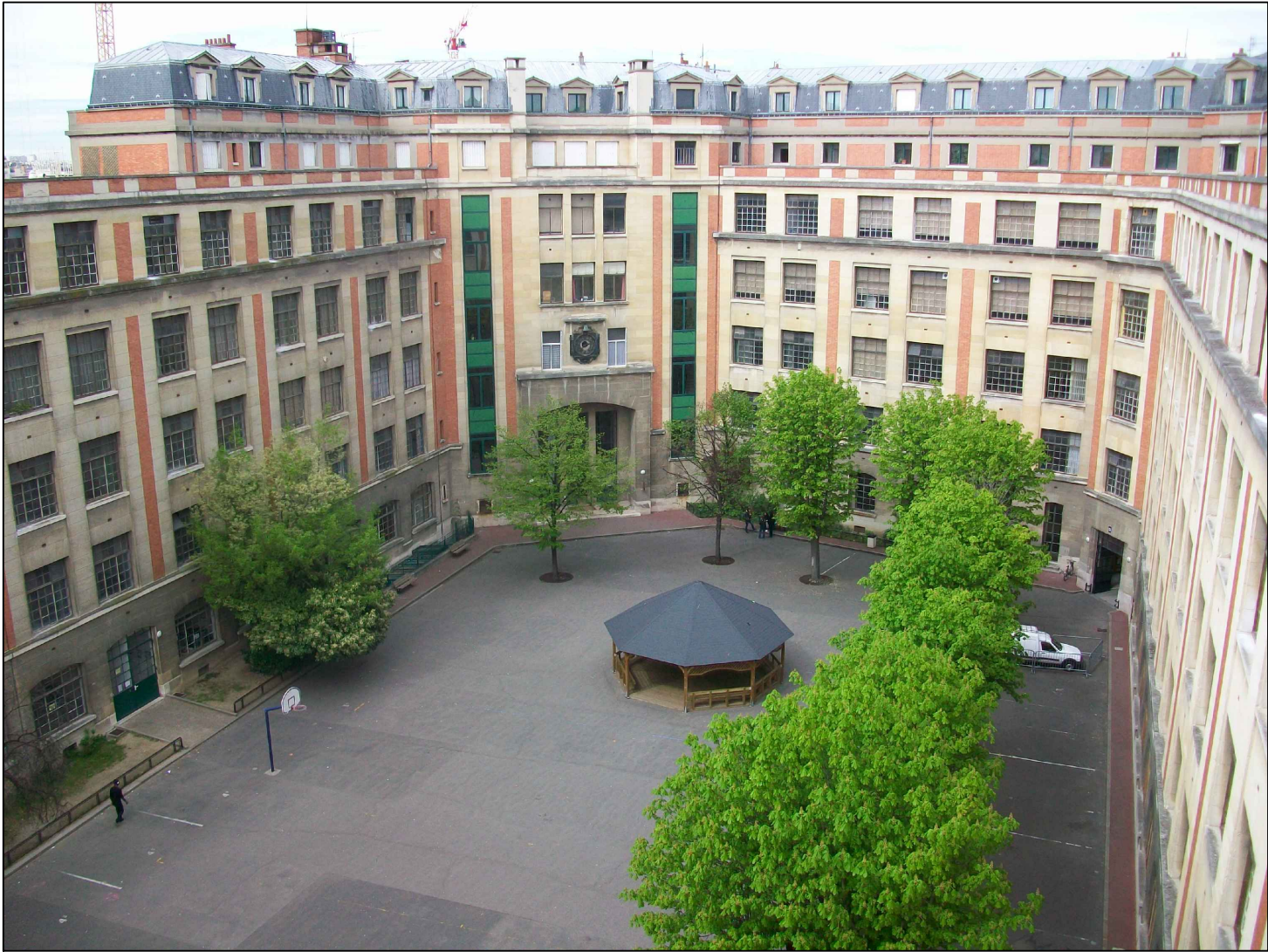
VUE D - vue plongeante sur la cour intérieure
