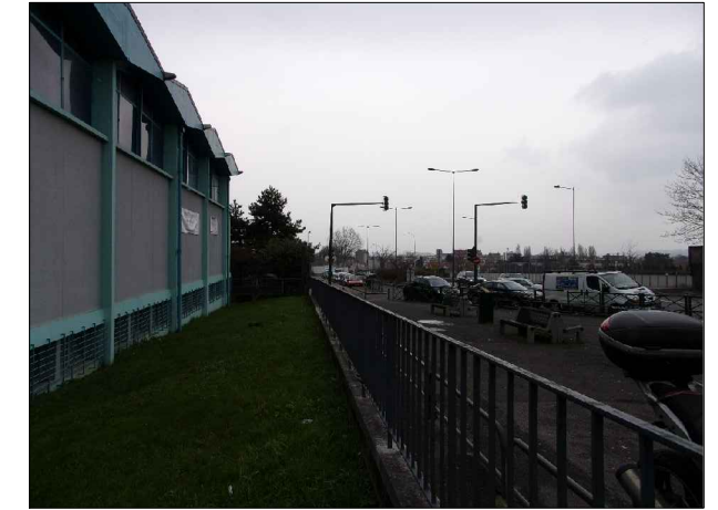
C.03 : Façade du gymnase - Bvd de Strasbourg
