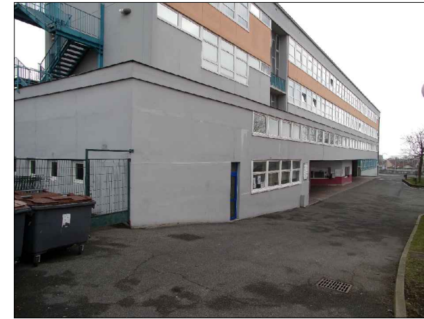
C.08 : Accès livraisons #1 - Rue Maréchal Joffre
