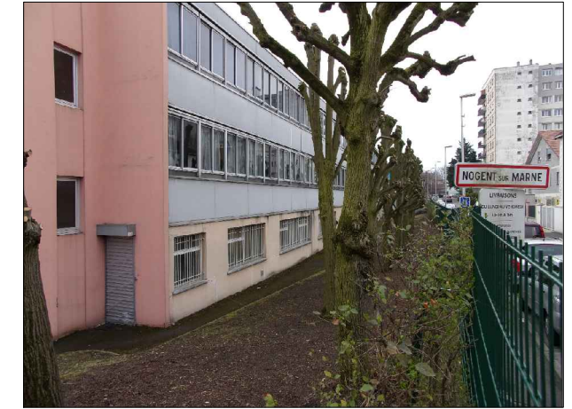
C.07 : Arrière bâtiment - Rue Maréchal Joffre
