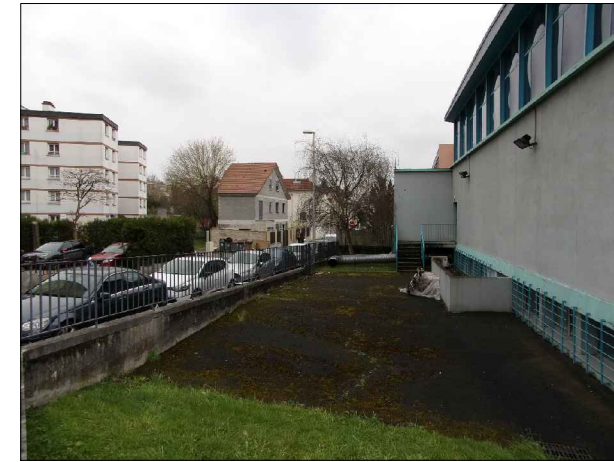
C.04 : Issue gymnase - Rue Maréchal Joffre
