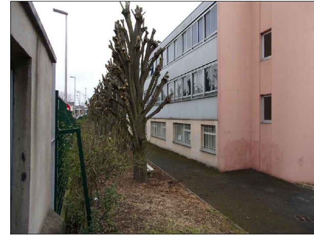
C.06 : Arrière bâtiment - Rue Maréchal Joffre
