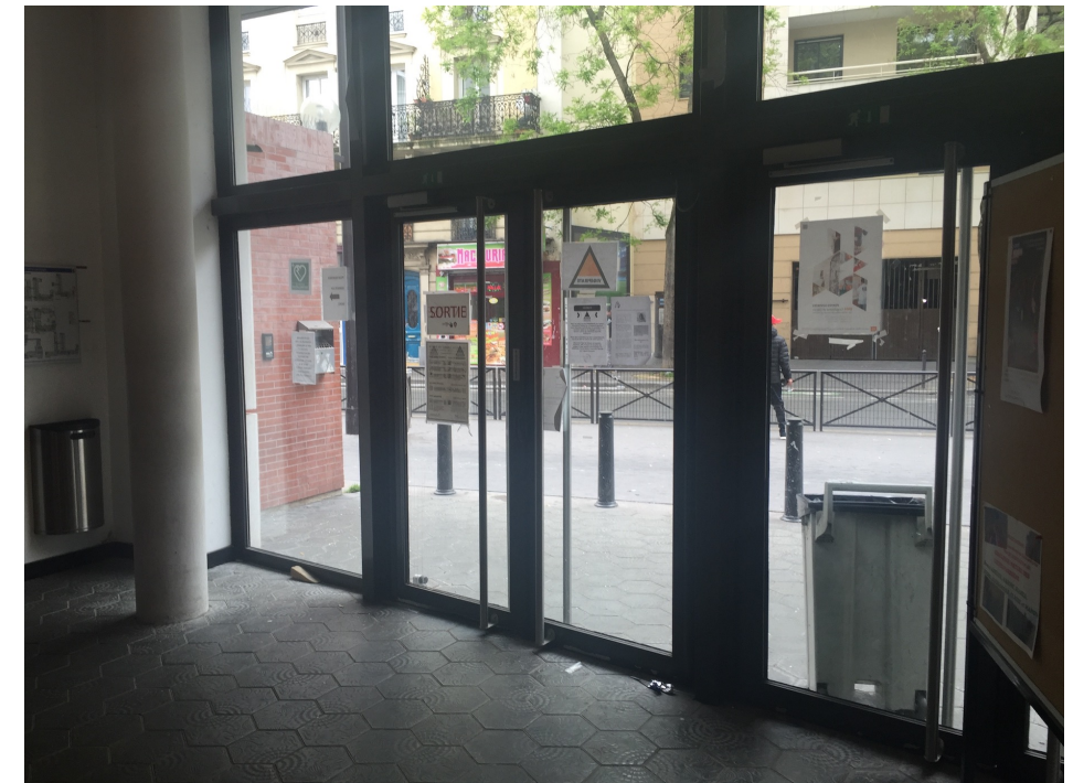
baie vitrée du hall à l'emplacement du sas
