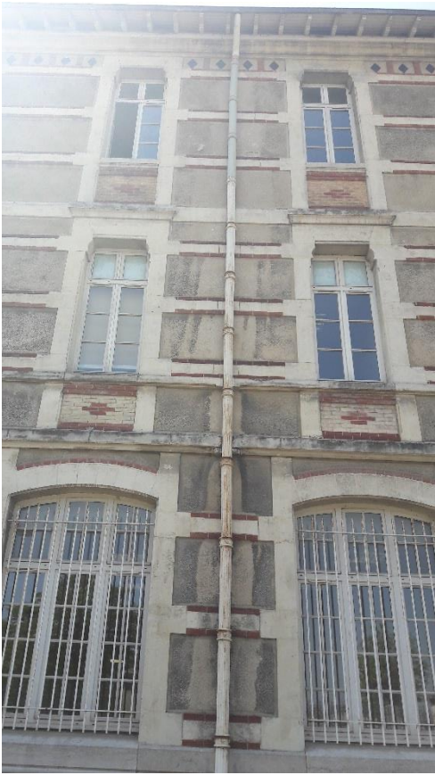
Photographie 7 : Défenses métalliques, écoulement des eaux pluviales
