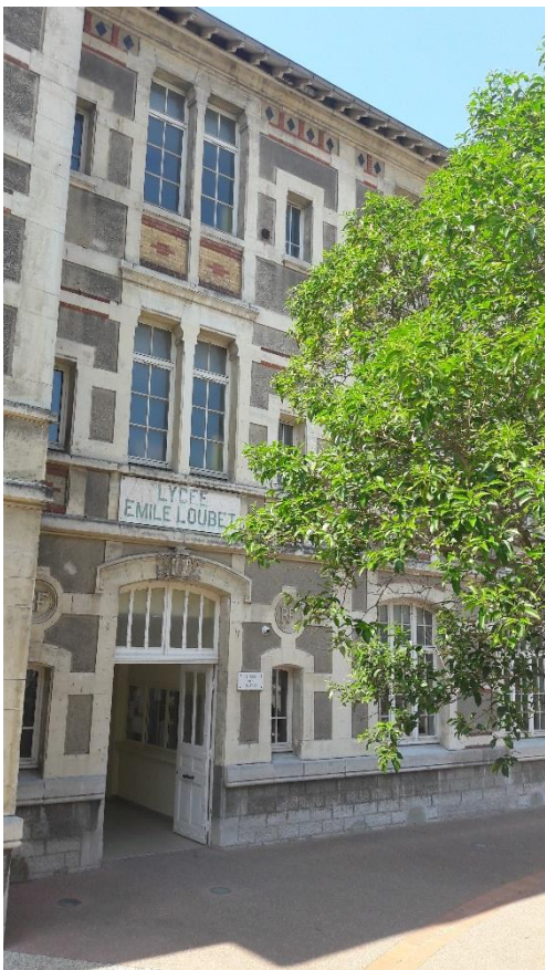
Photographie 10 : Porte gauche
