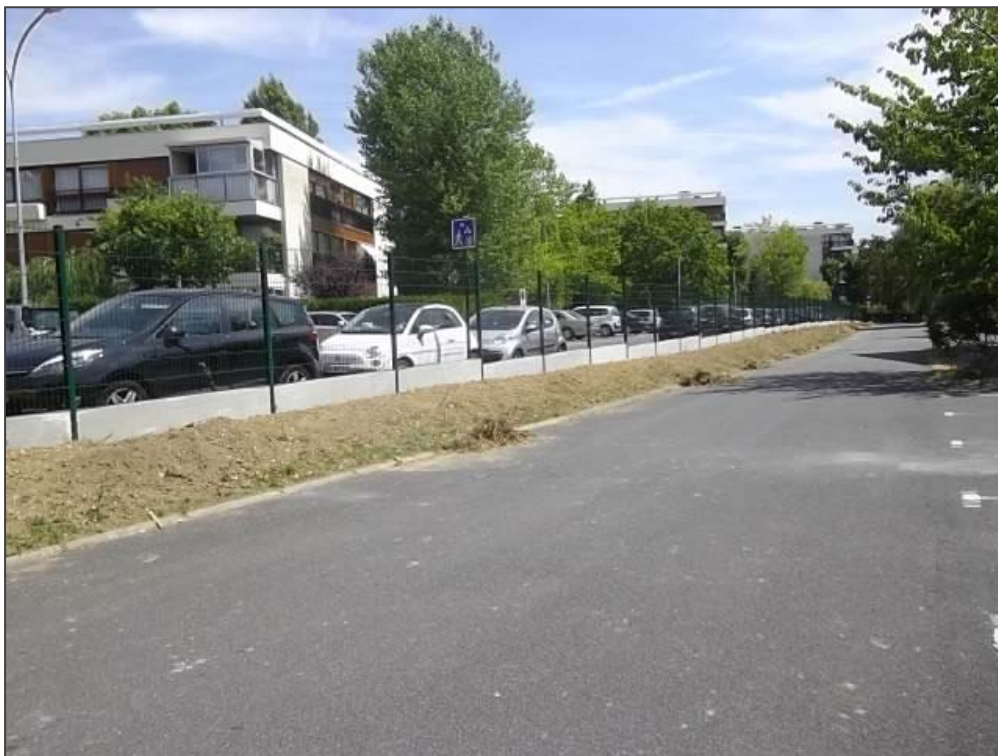
Clôture du Lycée Jean MOULIN au Chesnay réalisée cet été
