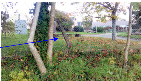
Perte de solidité et de stabilité / risque de chutes des poteaux et/ ou de personnes
