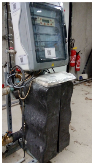
ECHANGEUR A PLAQUES CHAROT
