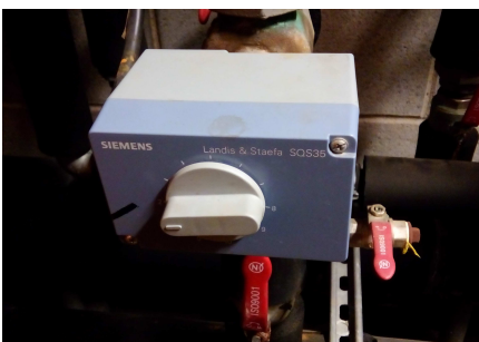
VANNE 3 VOIES SIEMENS
