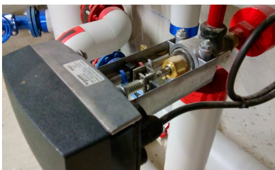
VANNE 3 VOIES SCHNEIDER
