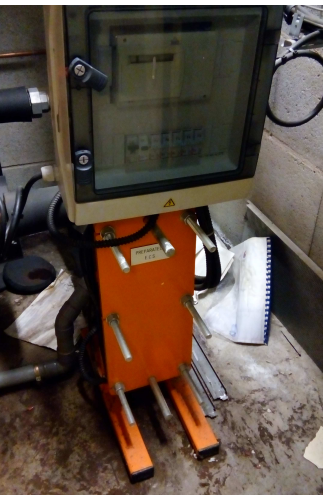
ECHANGEUR A PLAQUES CHAROT
