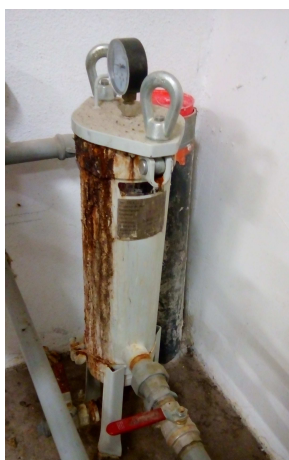
FILTRE A BARREAU MAGNETIQUE Permo
