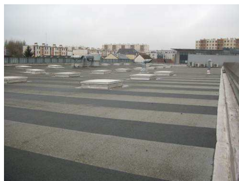
Toiture du bâtiment C
