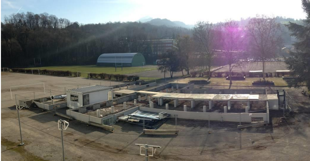
Vue d'ensemble du site à démolir
